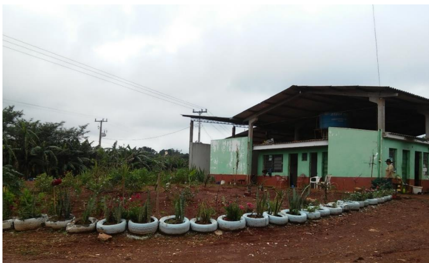
Figura 25. Entrada do Aterro Controlado de Palmital
