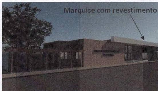
O Revestimento adotado inicialmente para esta marquise, conforme planilha orçamentária, item 1.8.0.9 – Placa Cimentícia Lisa E=6mm, de 1,2x2,5 m (sem amianto), foi escolhido para servir de acabamento sobre a estrutura, que contém um vão de aproximadamente 17 metros. **Cabe ressaltar que a utilização deste revestimento teve como premissa o baixo custo estipulado em planilha, não comprometendo o teto orçamentário estipulado para a obra de reforma da unidade.**
